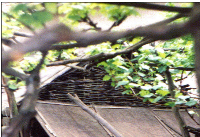
3. kép. Gazdasági építmény tűzfalának vízszintes sövényfonata (A szerző felvétele)
